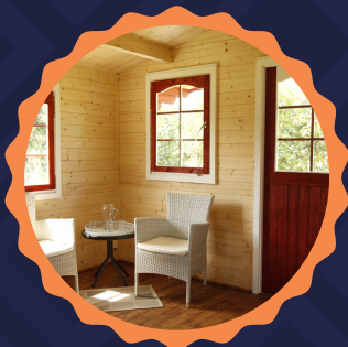
Drewniane ściany zabezpieczone olejem bielonym PAINT ECO
