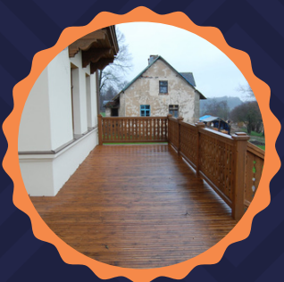
Taras zabezpieczony bejcą tarasową PAINT ECO
