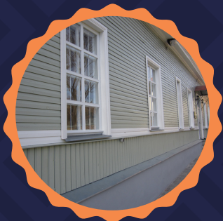
Drewniana elewacja malowana farbą PAINT ECO
